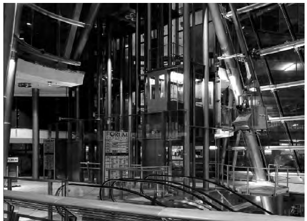
Núcleo de comunicaciones verticales en un centro comercial
