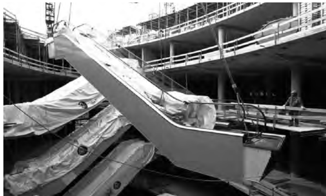
Escaleras mecánicas acopiadas en la obra y en curso de montaje
